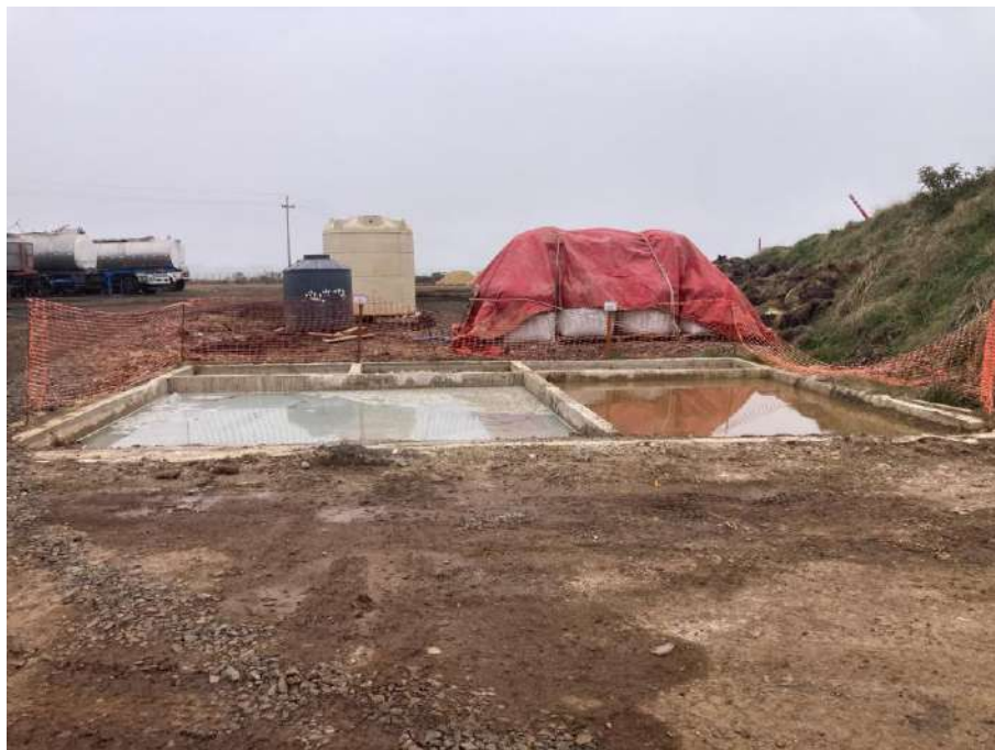
Imagen N°2: Piletas de lavado de mixers y herramientas con hormigón (izquierda) y piletas de efluentes de máquinas y camiones (derecha).
