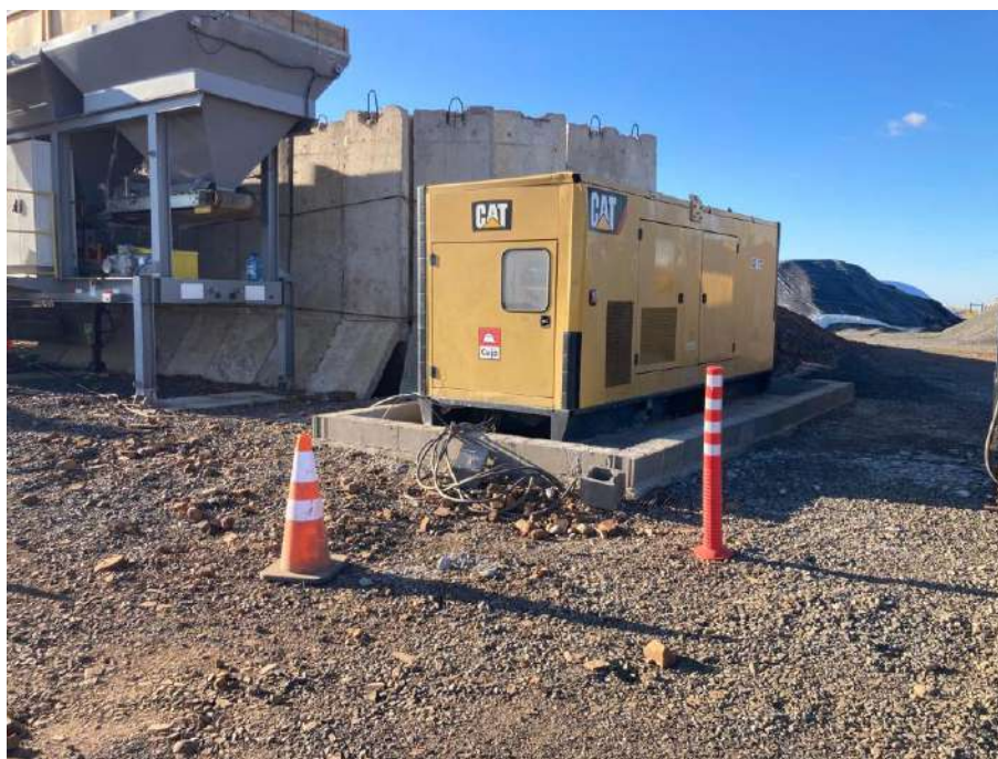
Imagen N°5: Bandeja para el generador de la planta asfáltica.
